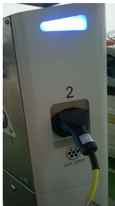
Figura 12: Particolare collegamento connettore
